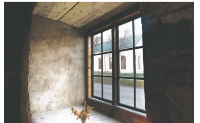
Stenhuset har 1,2 meter tjocka väggar av gråsten med inslag av tegel.
